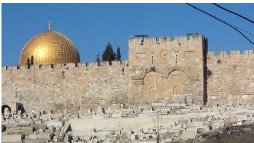
(Fig. 2. Porta selada e os túmulos bloqueando a passagem)
